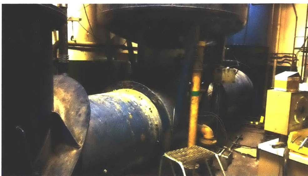
Figure 6-4: MIT cavitation tunnel upper and lower levels
