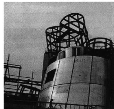
Figure 2.37: Stata Center, MIT
