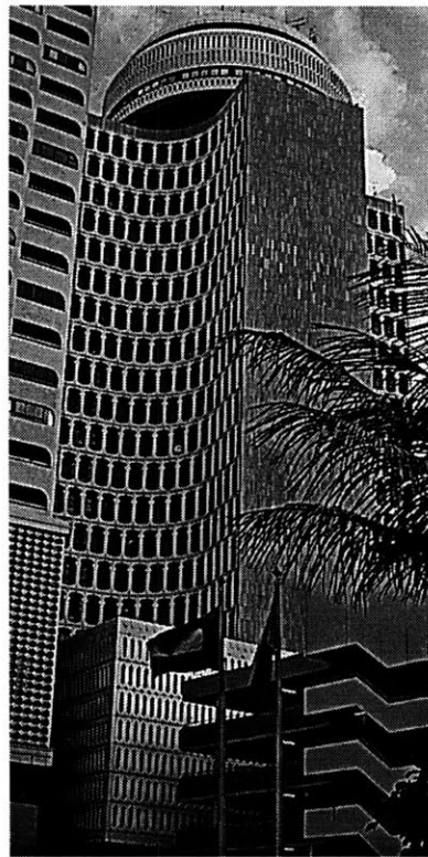
Fig. 14D Deira Tower
