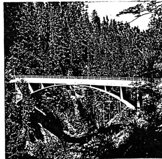
Schwandbach Bridge Fig. 73
