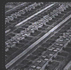
FOUNDATION AND GARDEN SHEDS, POURED EN MASSE
