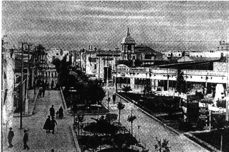
2.b-18. Fiera di Tripoli, 1929. View of central street.
