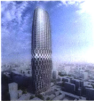
(d) Dorabanti Tower Concrete Filled Steel Grid 57 Stories, 200m
