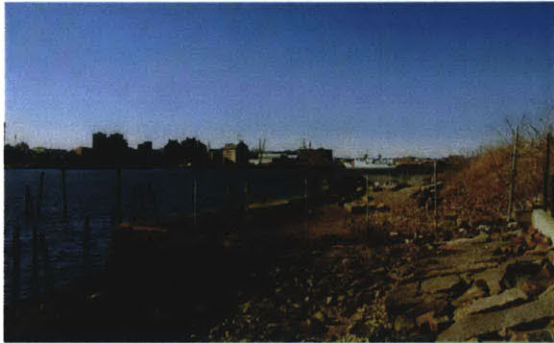
Existing edge condition
