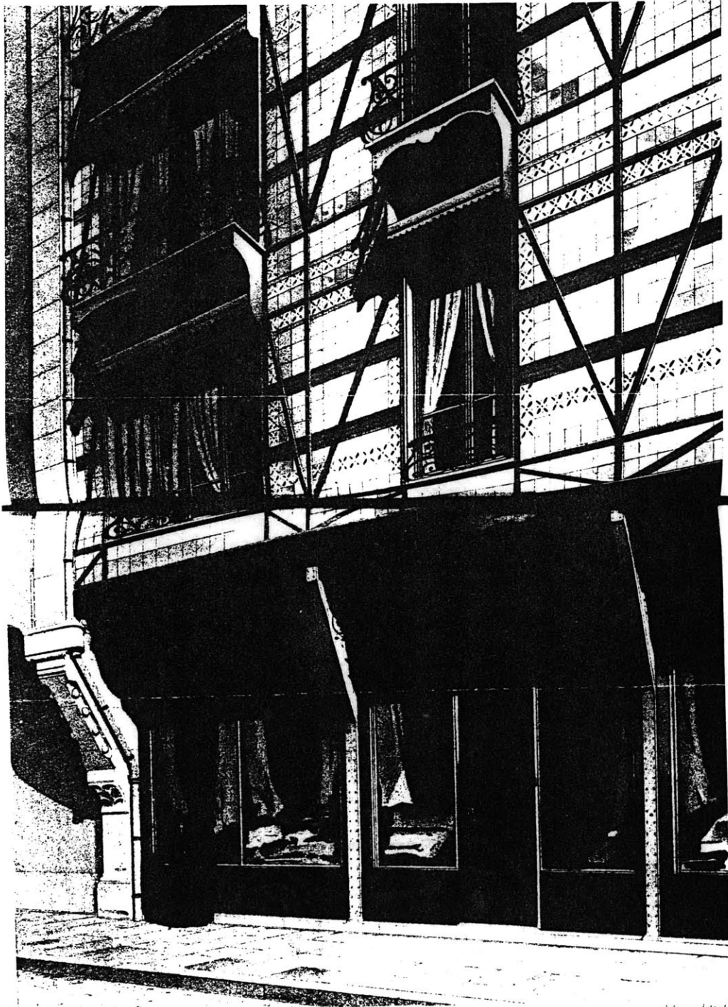
VIOLLET-LE-DUC PAN DE FER DE FAÇON EN FER. REVÊTEMENT AVEC REVÊTEMENT DE FAÏENCE. Goussier, Litnôg 1872
