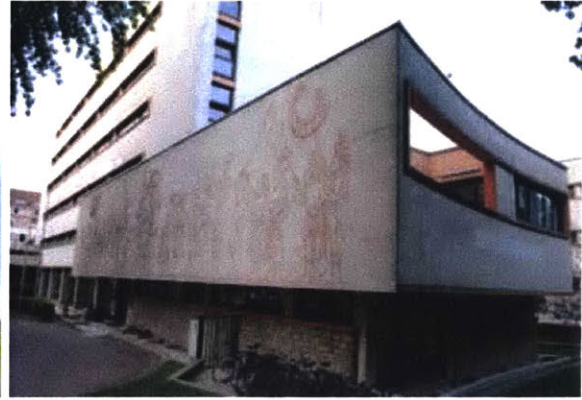
7.14. Maison du Mexique. Source: Author photo
