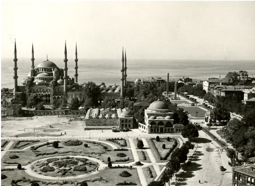
Figure 29 – View of the Sultan Ahmed Mosque from the Hagia Sophia Minaret, from Académie d'architecture, Cité de l'Architecture et du Patrimoine, Archives d'architecture du XXe siècle, Fonds Henri Prost, 343 AA 68.
