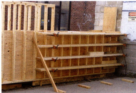
Fig. 68. Actual Setup of Formwork 1.
