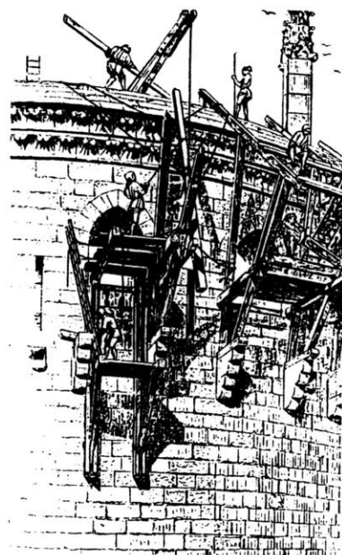
Construction des hours du donjon d'un château fort, au Moyen Âge (Roger-Viollet).
