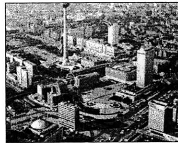
Aerial view of the current Alexander Platz. From Pysall. (1998) Das Alexander Der Haus Alexander Platz
