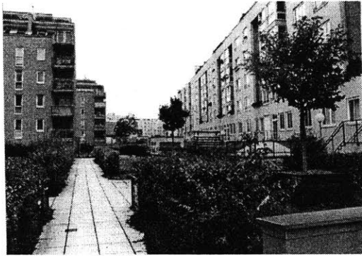
Fig. 5.11 - Courtyard, Wohnpark Rennweg
