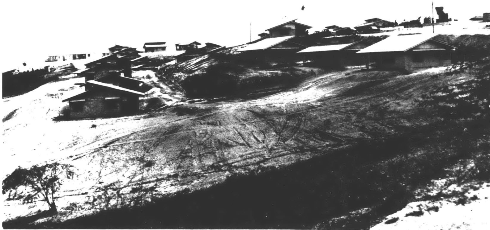
La Cité Magloire No 2 actuellement en construction comprend des types de maisons très confortables qui sont louées à bon marché. Il a fallu la ténacité du Président Magloire pour mettre sur pied ce gigantesque programme de relèvement de notre classe ouvrière
