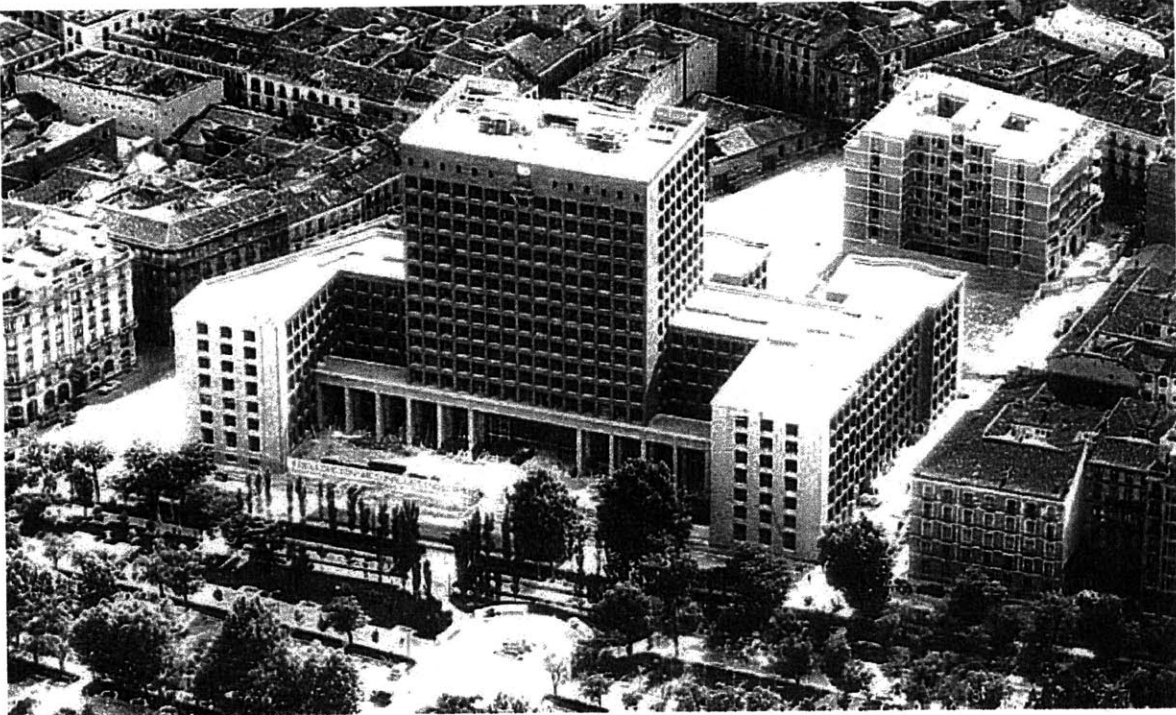
Fig.1 Francisco Cabrero and Rafael de Aburto. Casa de los Sindicatos, Madrid (1949)
