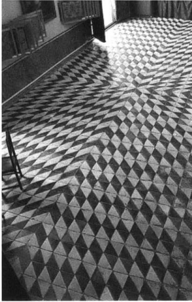
Figure 25. Azulejos of the main Chapel, Colegio del Arte Mayor de la Seda, 1756, Valencia.
