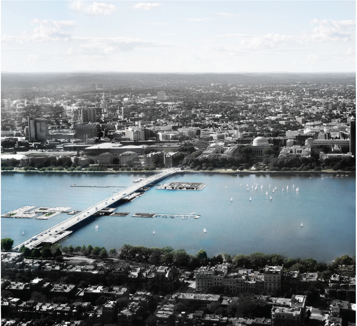
Figure 19.0 | Aerial View of MIT i 2
